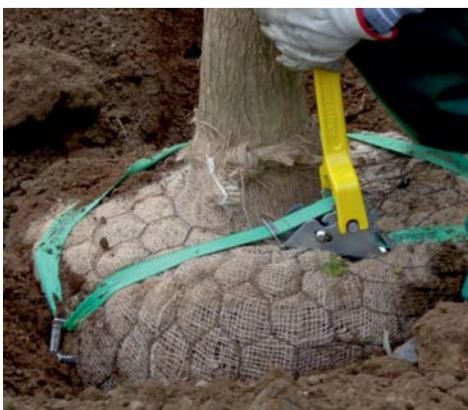
Baumverankerungssystem: Deadman Plati-Mat® & Spezial-Gurtband
