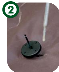
2 Rammstange entfernen
