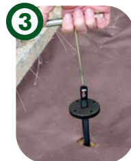
3 Erdanker verriegeln
